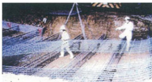
インバート部施工状況
