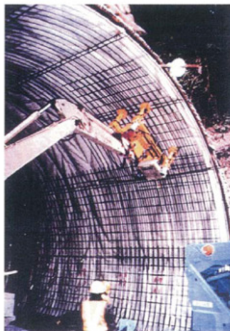
アーチ部施工状況 専用取付装置 (住倉鋼材開発: 施工時レンタル) をバックホーのバケット部と取替し、メッシュユニットを把持し、取付位置へセットする。
