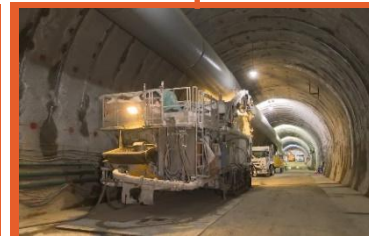
北海道新幹線トンネル (施工中)
