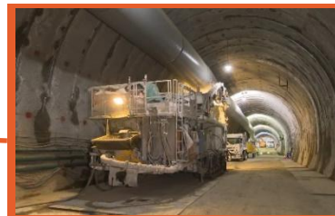
北海道新幹線トンネル (施工中)
