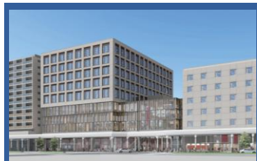
長岡市大手通再開発 (2026年竣工予定)
