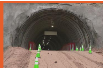
磐越自動車道四車線化
